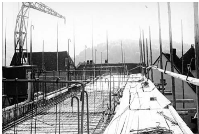
Über den Dächern von Schelklingen. Ein Kran half, das Baumaterial ganz nach oben zu bekommen.
