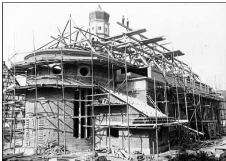
Der Neubau der Kirche. Ganz oben haben sich zwei – offensichtlich schwindelfrei – Arbeiter für das Foto aufgestellt.
